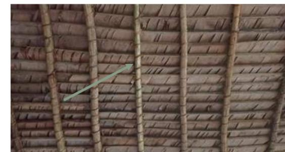
Utilisation des rameaux d'Hévéa dans la construction des toits traditionnels en « fitoroka »
